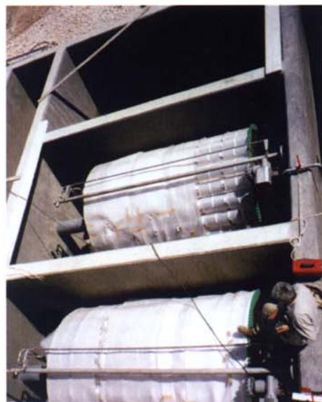
Z montáže filtrů na ČOV v Řecku
