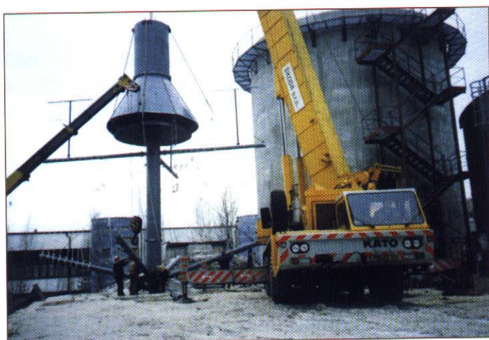
Montáž ZN 12/12 na zahuštění kaolinu
